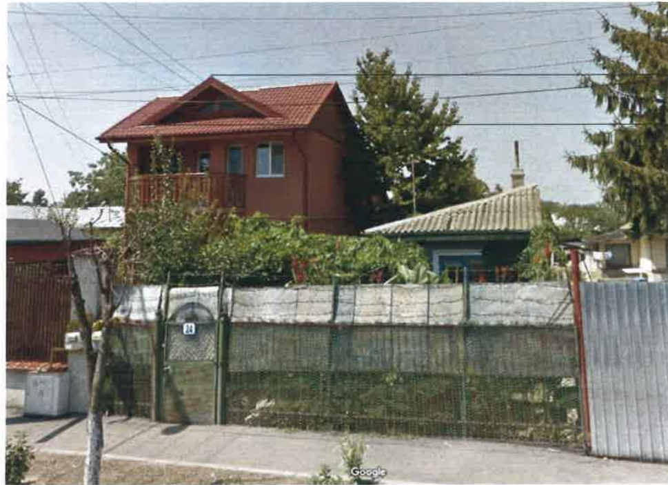
Fațada la strada Pietroșița- situația existentă
