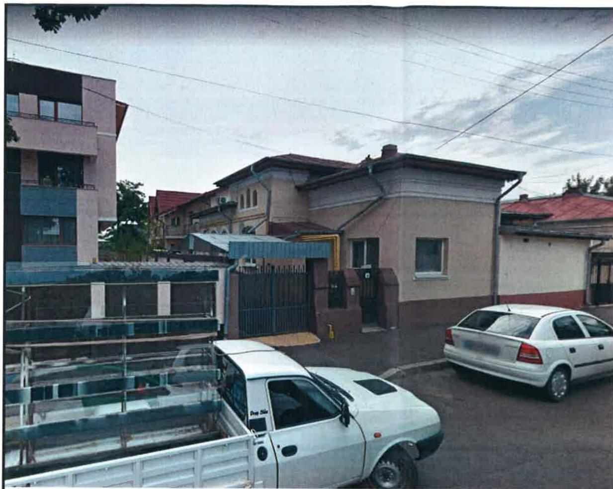
SITUATIE EXISTENTA - VEDERE SPRE FATADA
