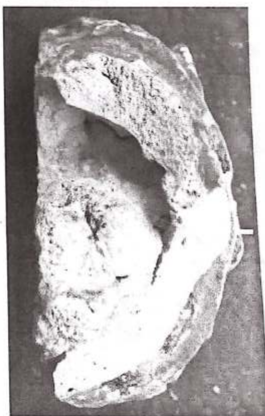
7. Vederi din profil, modul cu mortar, în dreapta, fără mortar în stânga. Se vede profilul de agățare.
