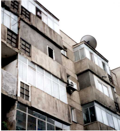
Balcoane cu închideri improvizate, geamuri, antene și aparate de aer condiționat care pot să cadă la seism sau furtună
